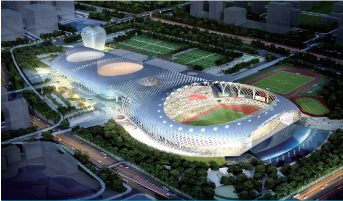
Hlavní místo konání Univerziády v Shenzhenu, celkový výkon VRF 1000 kW.
