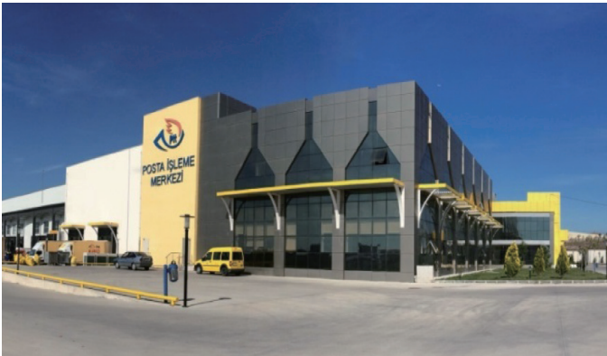
Kancelářské a provozní centrum PTT Istanbul v Turecku, celkový výkon VRF 2500 kW.
