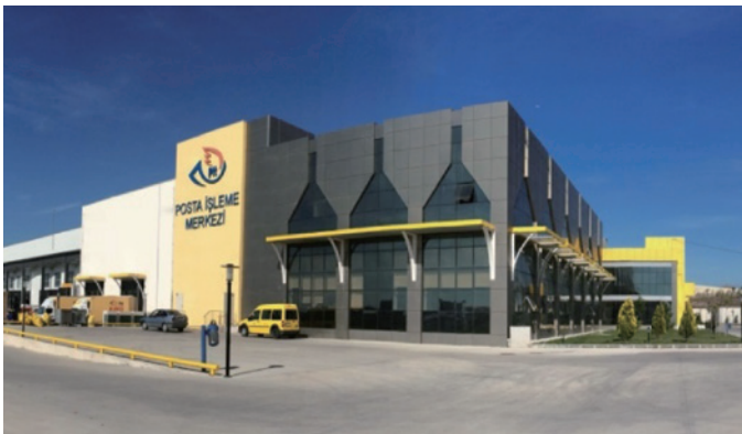
Kancelářské a provozní centrum PTT Istanbul v Turecku, celkový výkon VRF 2500 kW.
