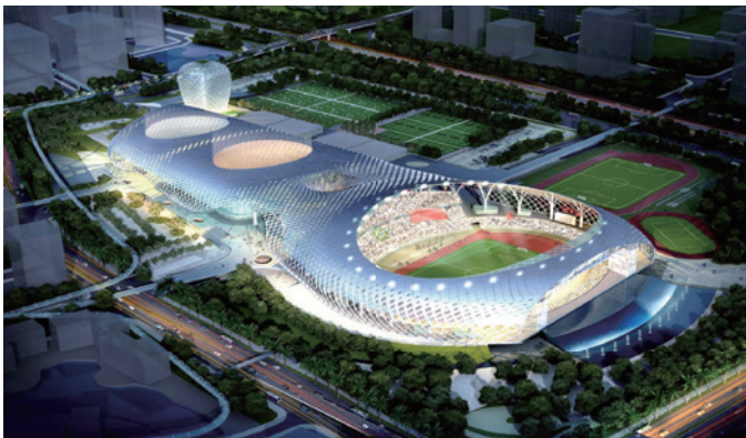
Hlavní místo konání Univerziády v Shenzhen, celkový výkon VRF 1000 kW.
